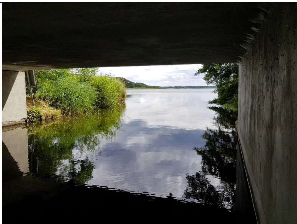
Straßendurchlass Mellensee in Nottekanal
