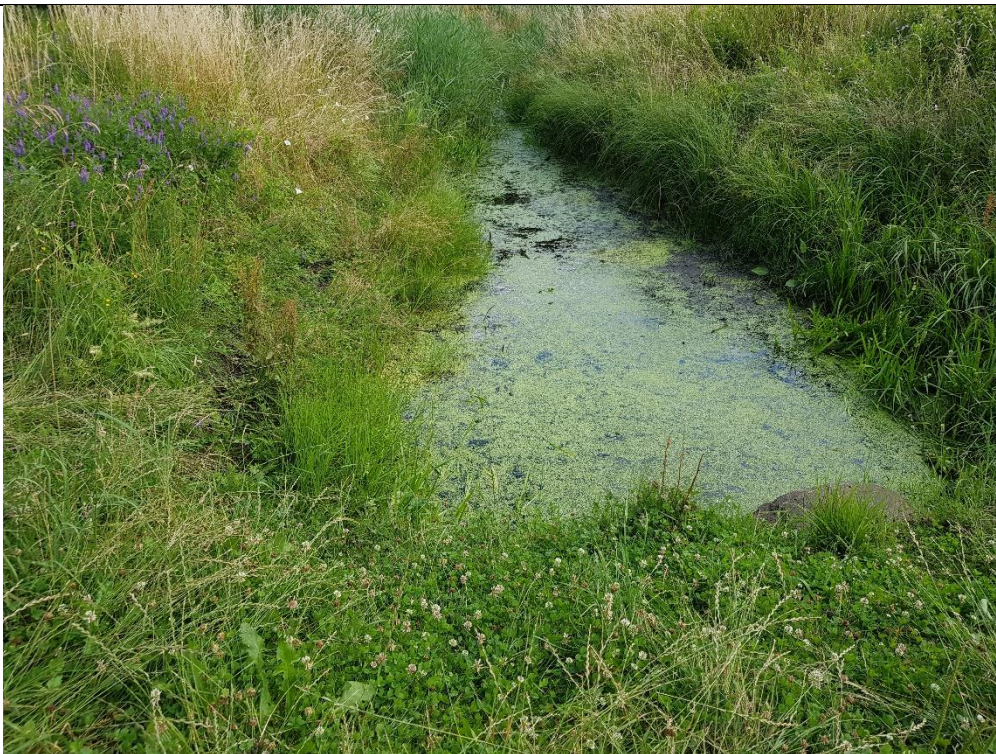
Abschlagsgraben aus dem Weichpfulhteich in den Weichpfulgraben
