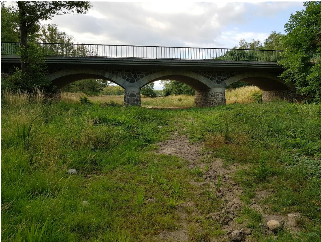
Straßenbrücke über das Staubecken
