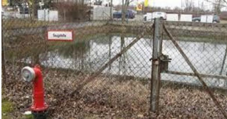
Abbildung 5: beispielhafter Löschwasserteich mit Saugrohr
