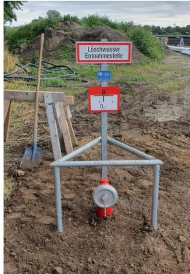
Abbildung 1: beispielhafter Löschwasserbrunnen für Saugbetrieb
