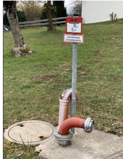
Abbildung 4: Ansicht Saugstelle, Lüftungsröhr nach Fertigstellung
