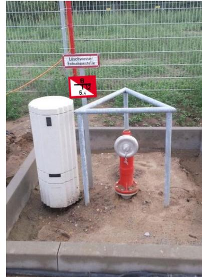
Abbildung 2: beispielhafter Löschwasserbrunnen mit Tiefpumpe
