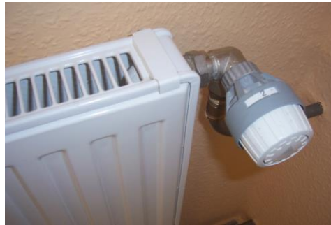
einstellbares Ventil im Ämterflügel
