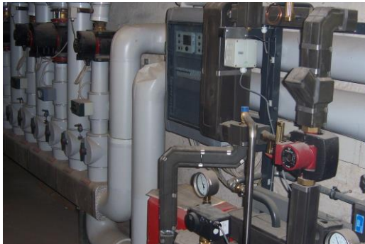
Fernwärmeanschluss
