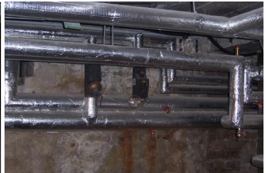
gedämmte Heizungsrohre
