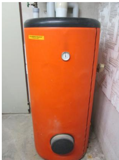
Warmwasserspeicher für die Turnhalle und die Schule, Entkalkungsanlage
