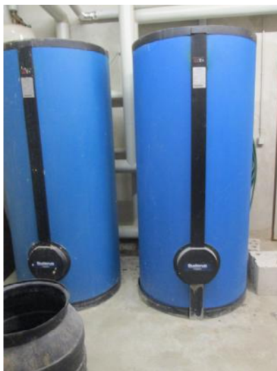
Warmwasserspeicher für die Turnhalle und die Schule, Entkalkungsanlage
