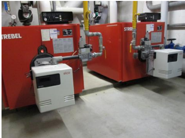
Heizkessel (baugleich) mit Typenschild
