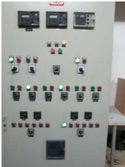
Heizungsregelung und -verteilung
