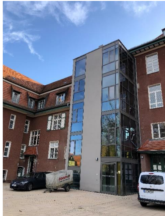
Abbildung 2: Gymnasium Jüterbog, Außenansicht
