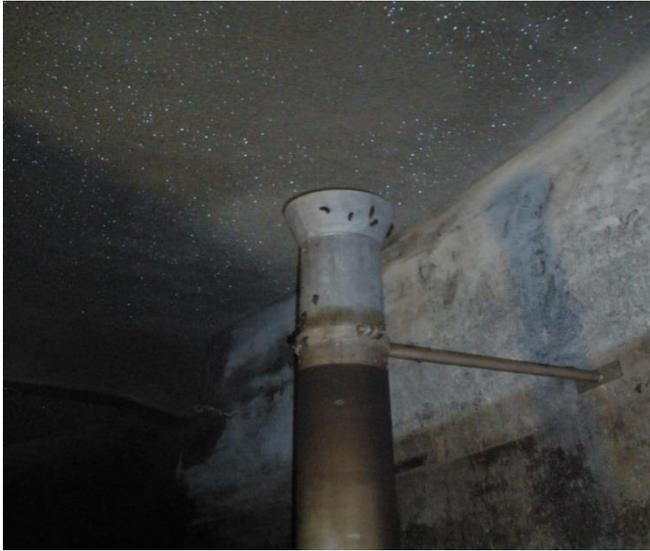
Im Hochbehälter eines Wasserwerkes wurden am Überlaufsystem „Nacktschnecken“ gefunden. Diese gelangten über ein Schachtsystem in den Wasserspeicher. Es wurden unverzüglich entsprechende Sanierungsmaßnahmen durchgeführt. Eine Gefährdung der menschlichen Gesundheit war nicht zu besorgen, so dass keine Verwendungseinschränkungen ausgesprochen wurden.
